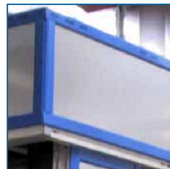
Материал коробов – листовая алюминий, степень защиты – от IP 20 до IP 54
