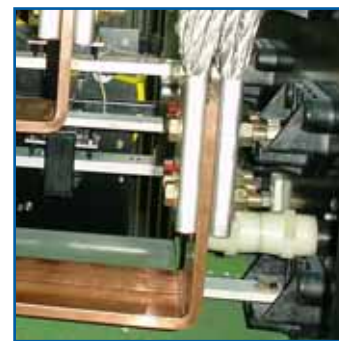
Регулируемые внешние соединения с шинами системы ERIFLEX® FLEXIBAR или с другой ошиновкой
